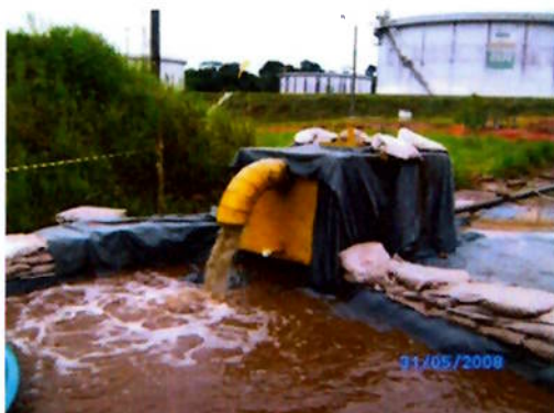
Figura 2.21: Limpeza da tubulação
