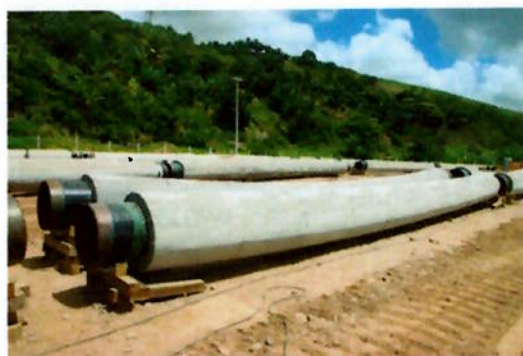
Figura 2.9: Tubos Concretados
