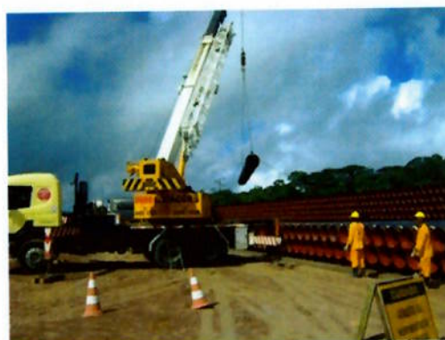
Figura 2.6: Manuseio de tubos
