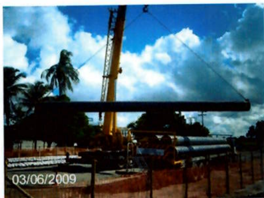
Figura 2.5: Manuseio de Tubos
