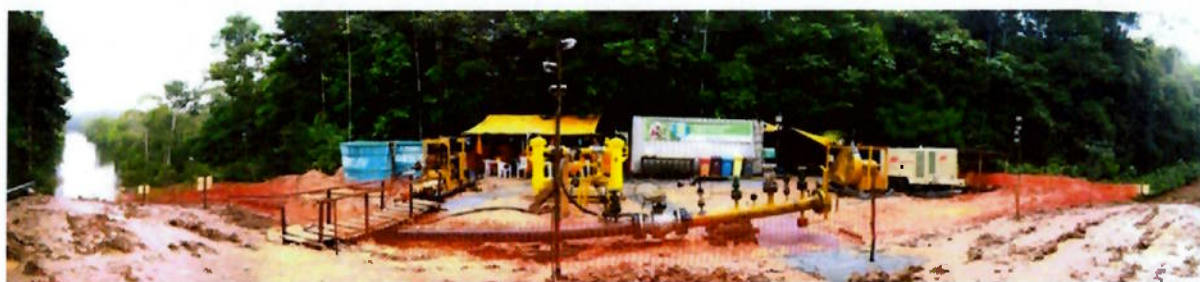
Figura 2.23: Panorama da fase de Teste Hidrostático
