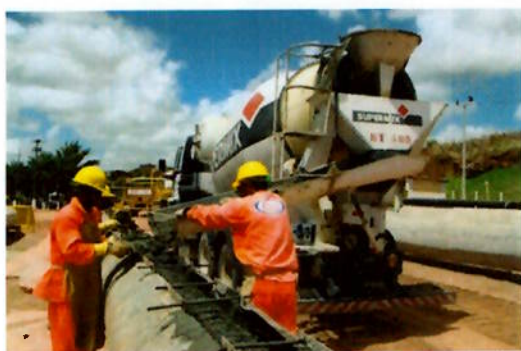
Figura 2.8: Concretagem de Tubos
