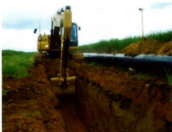
Figura 2.10: Abertura de Vala
